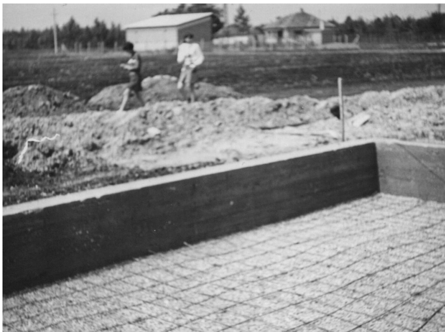
A gázcsere épülete és strandfürdő építése 1967
