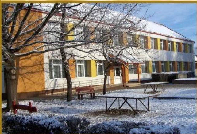
Az iskola felújítása
